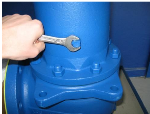
Abb.2 Verschließen der Entwässerungsbohrung
