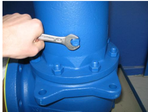
Abb.2 Verschließen der Entwässerungsbohrung
